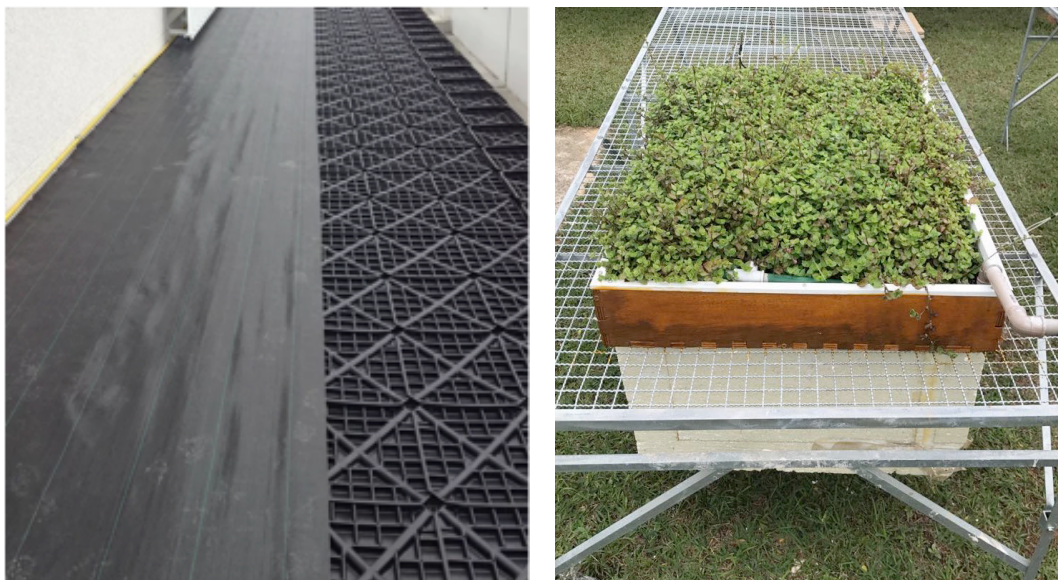
FIGURA 1. Ao lado esquerdo, figura do sistema FLAT instalado sobre uma laje, à direita, figura do protótipo com o sistema FLAT instalado, com a vegetação se desenvolvendo
