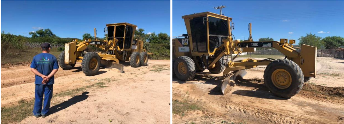
Figura 1. Motoniveladora regularizando a pista de rolamento (Fonte: Autores, 2020).
