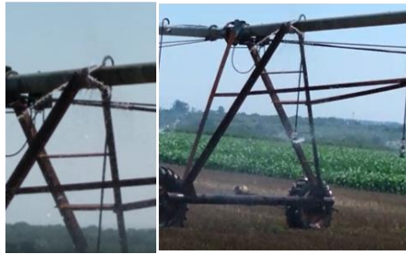
FIGURA 2. Vazamento no início da bengala de dois aspersores no final do 9º vão e início do 10º vão.
