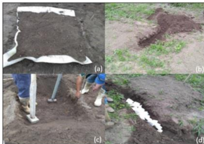
FIGURA 1. Canteiro com lona (a), Construção dos drenos laterais (b), Construção canteiro compactado (c), Utilização de isopor como material inerte drenante nos drenos laterais (d).
